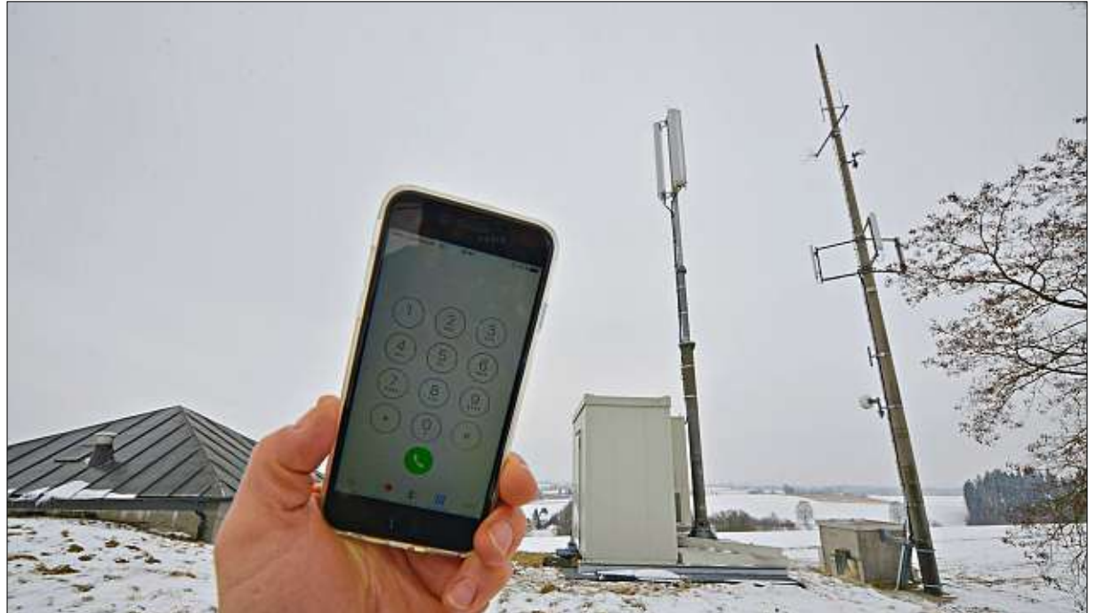
Früher haben O2 und E-Plus, Telekom und Vodafone vom BR-Mast (rechts) in Allertsöd gefunkt. Doch da mussten die Antennen runter. Die Telekom hat auf dem Wasserhochbehälter eine provisorische Antennenanlage errichtet (links). In Mailham entsteht jetzt ein neuer Funkmast. – Foto: Jörg Schlegel
